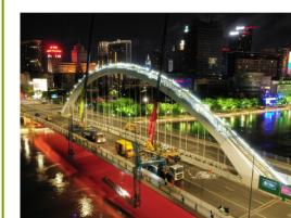
11月7日凌晨，琴桥结束夜间封道作业，恢复正常交通。此次琴桥结构维修，除了将桥梁的17对、34根吊杆全部更换外，还要对桥梁主拱、箱梁进行全面检查和维护，消除结构安全隐患，同时完成主拱、梁底的涂装和吊杆灯带的拆卸。项目部全程安排夜间施工，倒排时间抢工期、优化工艺工法抓进度，仅用25天即完成全部34根吊杆更换。
