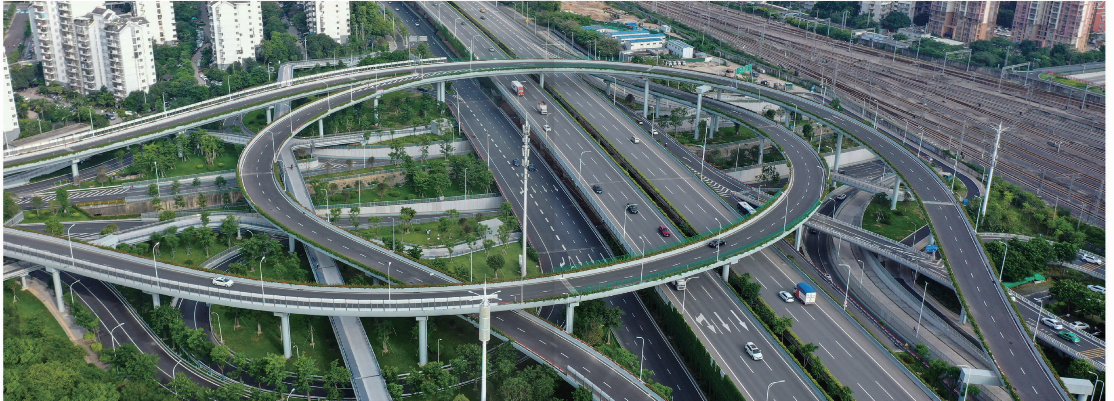
福州火车北站周边道路提升
