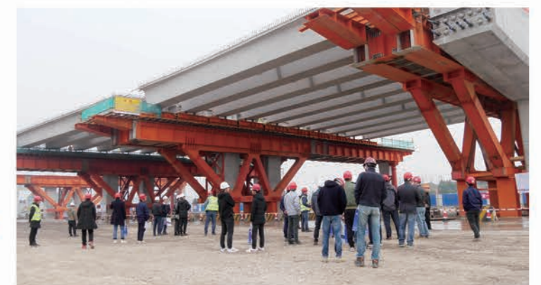
基于预制小箱梁的隐盖梁支承体系观摩
