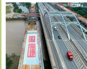
9月28日下午，鄞州大道快速路(机场路—鄞横线)工程IV标段跨奉化江特大桥全线成功合龙。该桥上部结构采用三跨变截面钢构桁架，桥梁跨径为101.3米+155米+106.5米，桥梁分为南北两幅，上层桥面为快速路机动车道，下层桥面为过江人行步道，采用了履带吊、龙门吊、滑移法和自行研制的悬臂吊装架桥机等多种施工吊装工艺。
